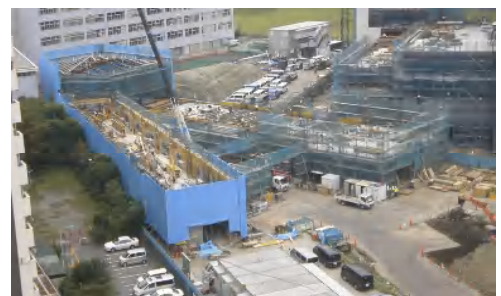
短大校舎建設工事、着々と進行中！
